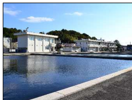
小鷹野浄水場
