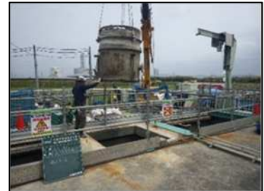
【老朽化した処理場の改築工事】
